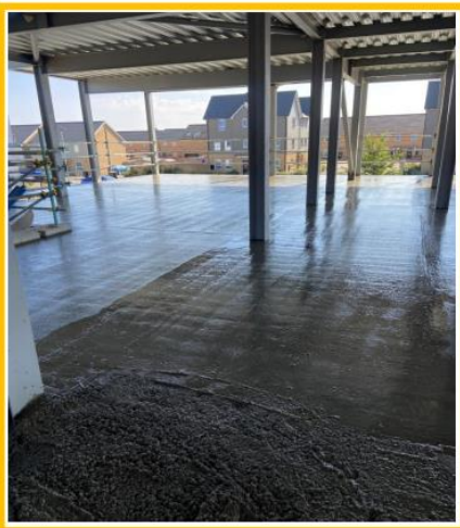
1 st floor slab pour in progress.
